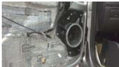
Основание подиума готово и установлено
