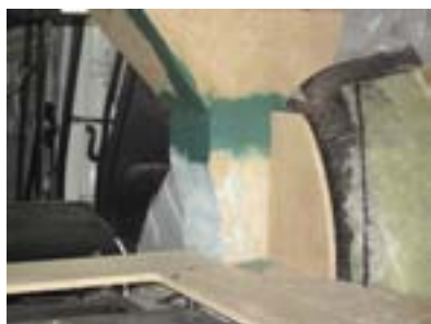
В конструкции подиумов для СЧ и ВЧ-излучателей использовались детали из акрилового стекла. При окончательной настройке объём одного из подиумов СЧ искусственно уменьшили перегородкой
